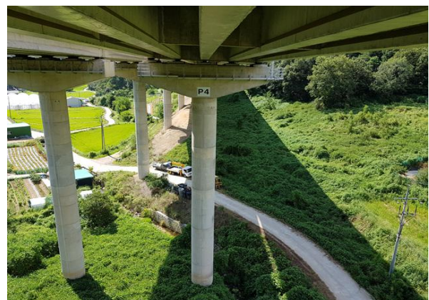
교각 P4 기초 전경
