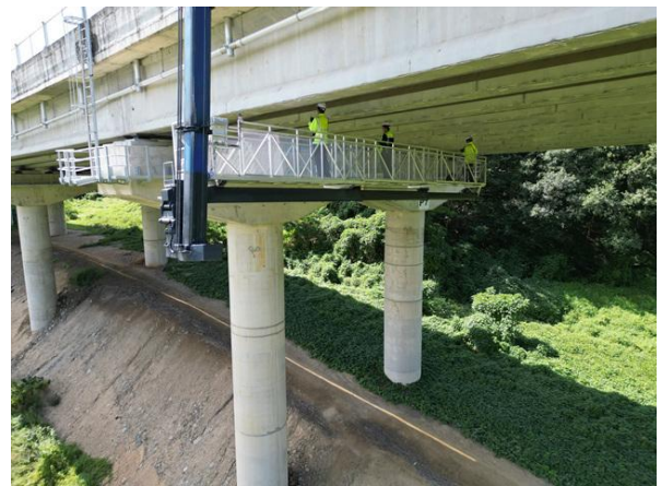
굴절점검차를 이용한 근접조사
