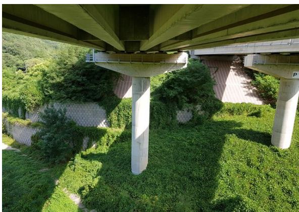
교각 P1 기초 전경
