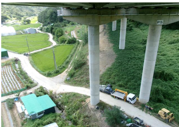
교각 P5 기초 전경
