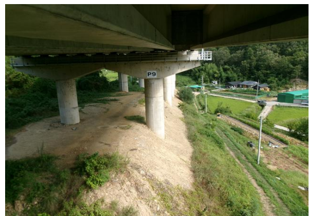
교각 P9 기초 전경
