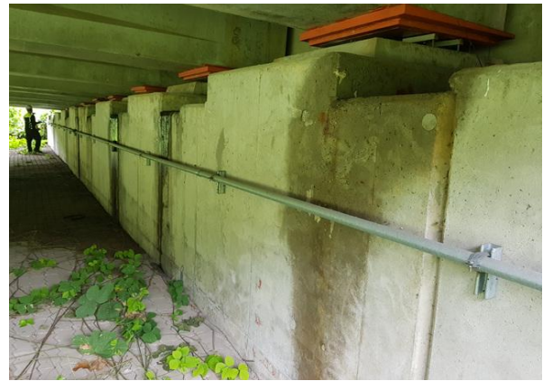
교대 A2 기초 전경
