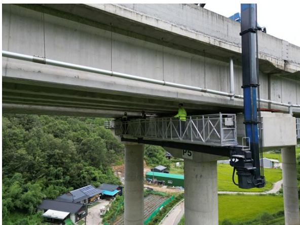
굴절점검차를 이용한 근접조사
