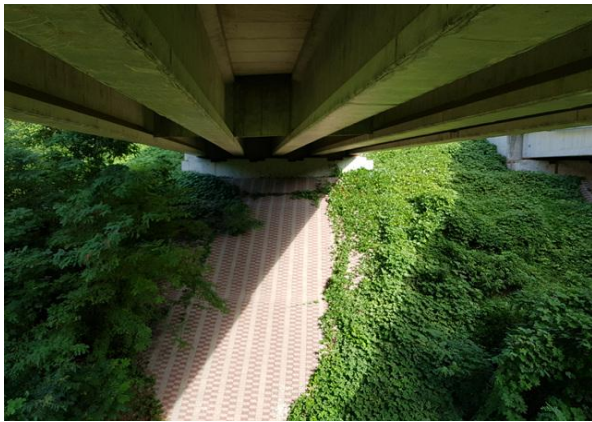
교대 A1 기초 전경
