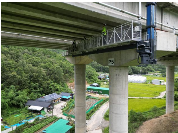
굴절점검차를 이용한 근접조사
